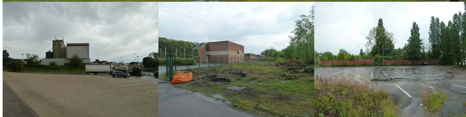
Bruggen, wegen, infrastructuur
